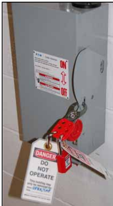
Figure 2-17: Ejemplo - Desconexión principal de CA con Bloqueo/ Etiquetado
