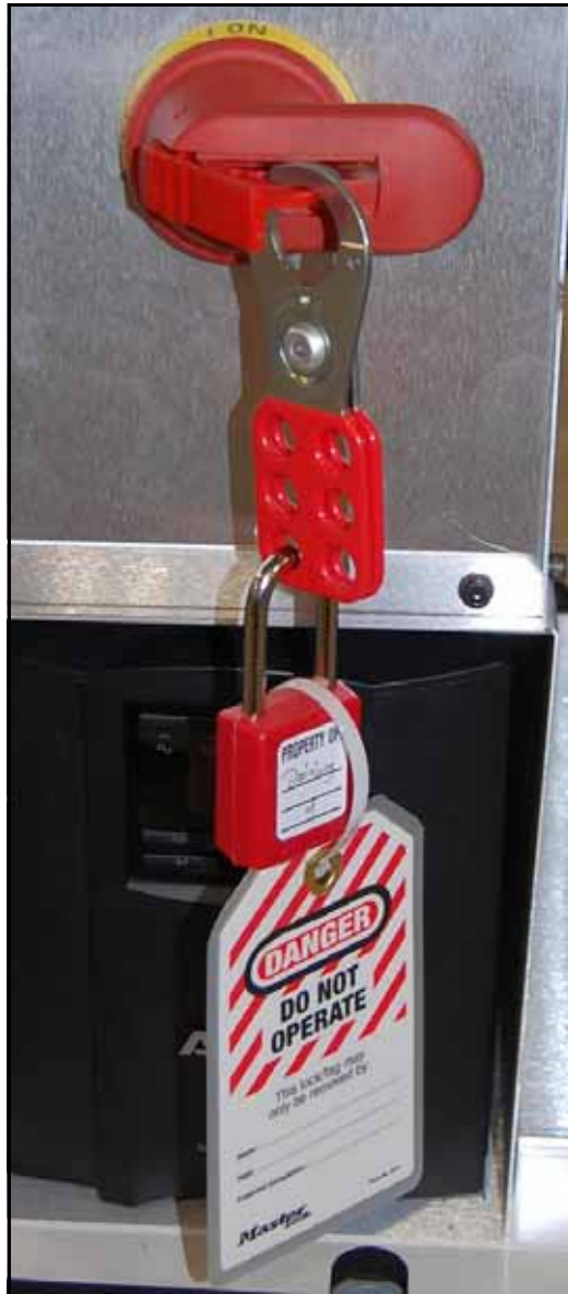
Bild 2-15: Verriegelungslasche mit Haspel, Vorhängeschloss und Schild
