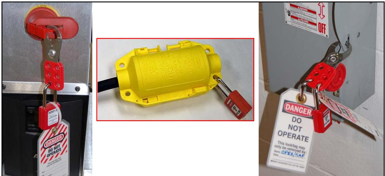
**Figura 2-9: Exemplos de Dispositivos LOTO Instalados**
