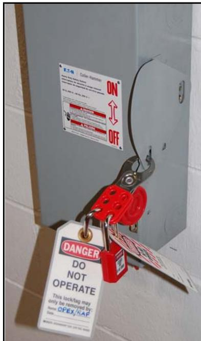
**Figura 2-17: Exemplo - Desconexão Principal CA com Bloqueio/Sinalização**
