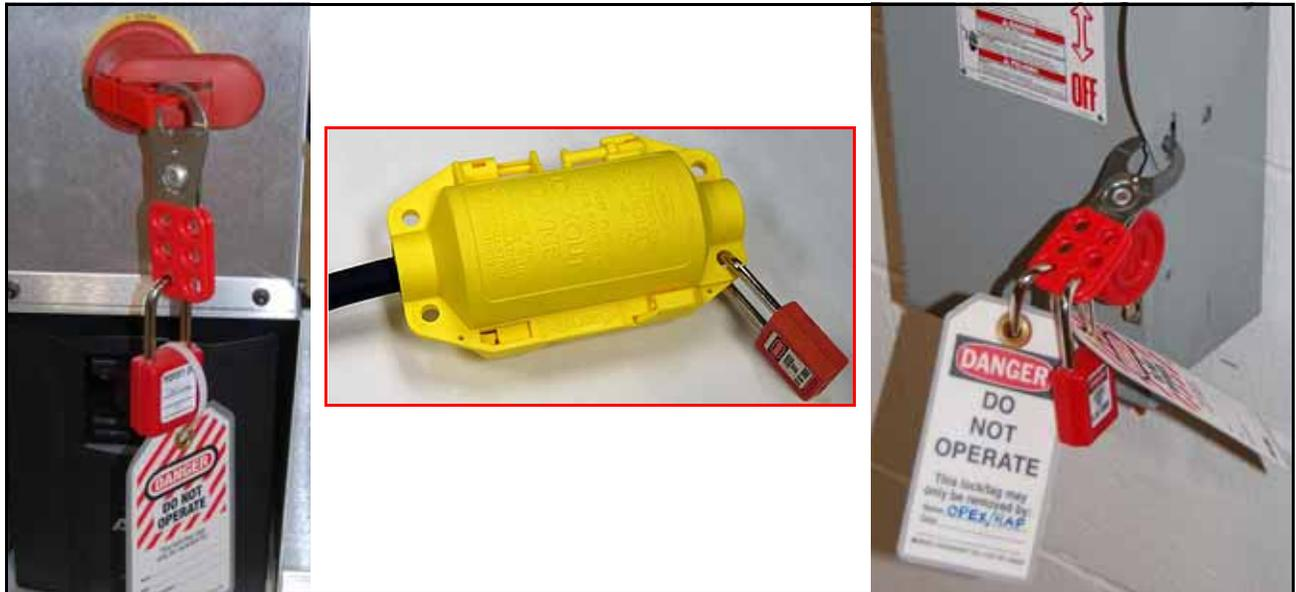
**Figure 2-9: Ejemplos de Dispositivos LOTO Instalados**
