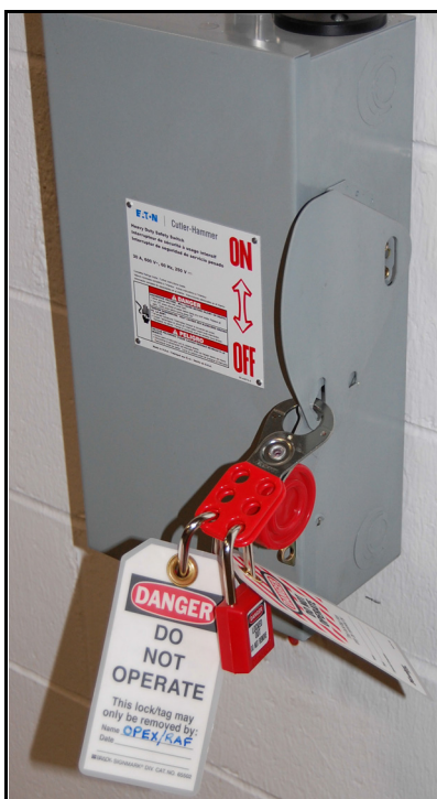
図 2-18 : 例 - ロックアウト / タグアウトデバイス付きメインの AC 切断
